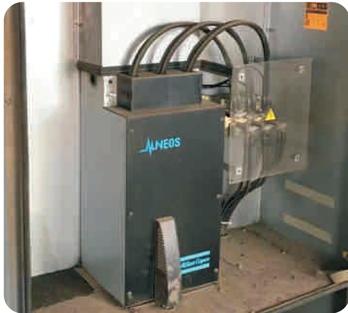
空压机增装节能变频器
